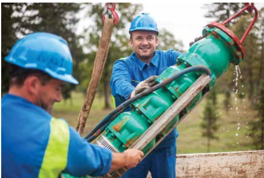
Črpalni agregat vidimo po 35.000 urah obratovanja. Agregat bo servisiran in nato ponovno vgrajen v vodnjak.
