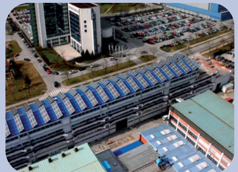
Sončna elektrarna Energetike Ljubljana
